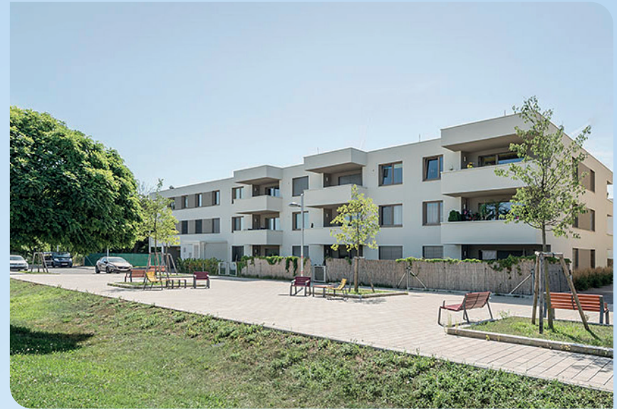
Referenzobjekt 1210 Wien, Marinonigasse 8-10
